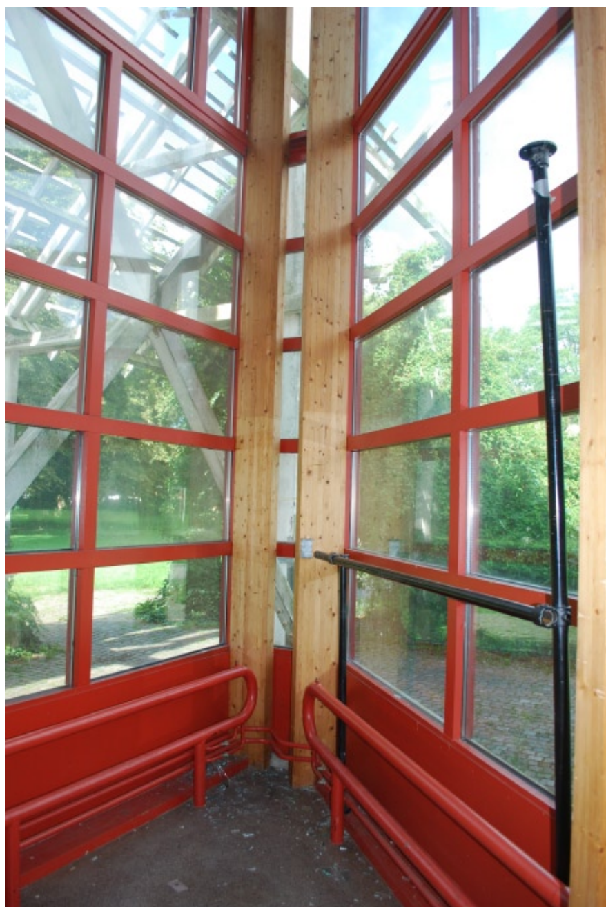
Nordvästra spetsen där glaspartier och husets träkonstruktioner möts
